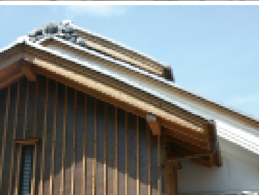
屋根・棟の重なり
