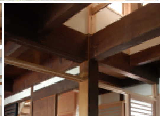
1階・吹き抜けからの見上げ
