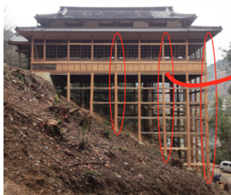
平成26年11月 本体修復完成時
